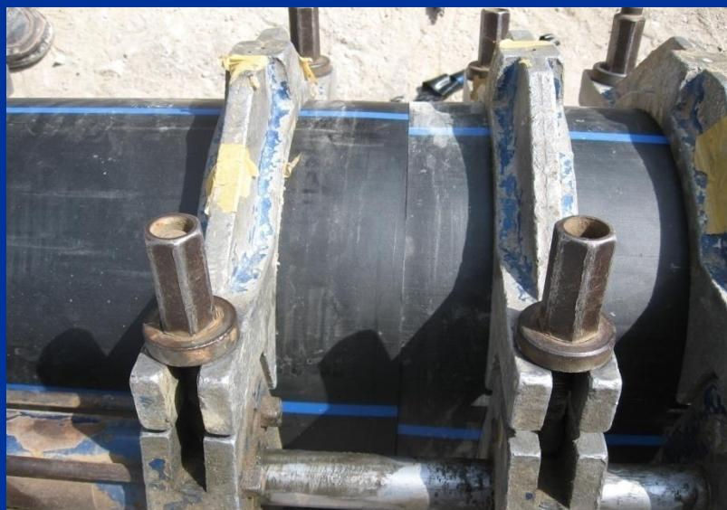
■ 3、将铣刀放入机架上，开动铣刀，操纵液压系统，使动夹具前进至铣刀刀盘，减小液压系统前进压力，使管材端面完全紧贴于刀盘上，进行铣削，直至铣削出连续带状余料，保证管道两端是一个平面后，将动夹具退出，关闭铣刀。
